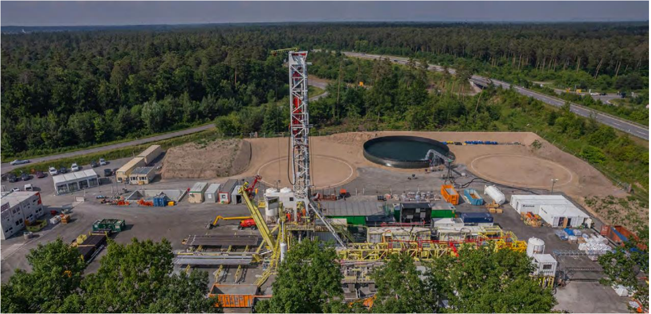
Abbildung 25: Drohnenaufnahme des Bohrplatzes in Graben-Neudorf (Deutsche ErdWärme GmbH, 2022)
